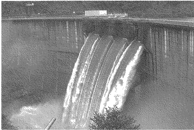
【 東海豪雨時のダム放流状況 】
