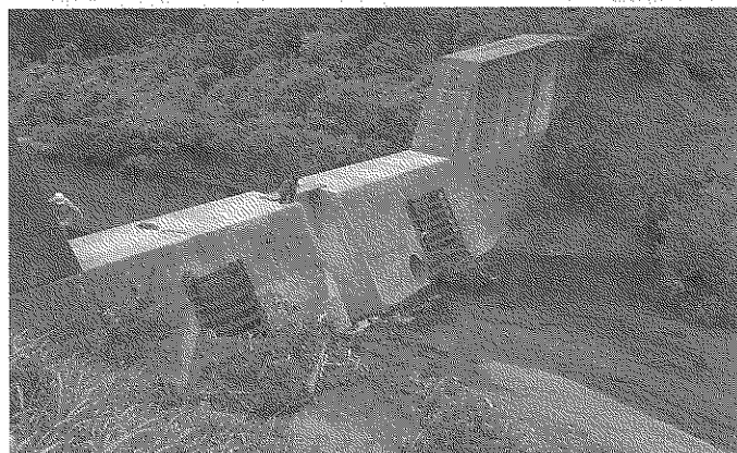
【国交省飯豊山系砂防事務所管内にある既存ダムスリット改修状況、スリットを開けたことで上流側が大きく空き状態になっている】
