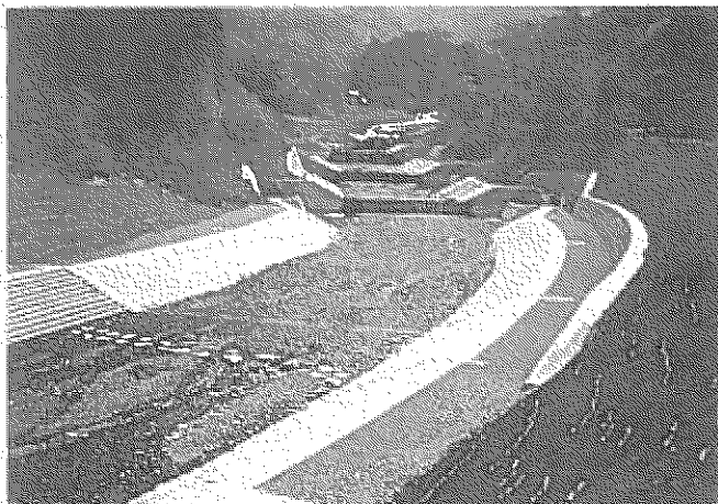
96年6月 床固工工事（大小10基）終了後全景
