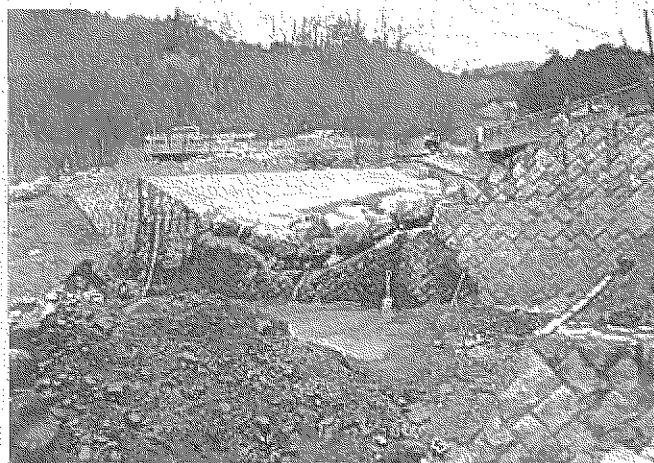
02年11月 床固工掘削と親石の設置
