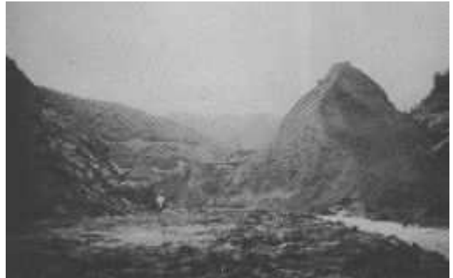
1951年7月10日の大雨で決壊した平和池ダム跡 (写真提供:柏原平和池水害伝承の会)
