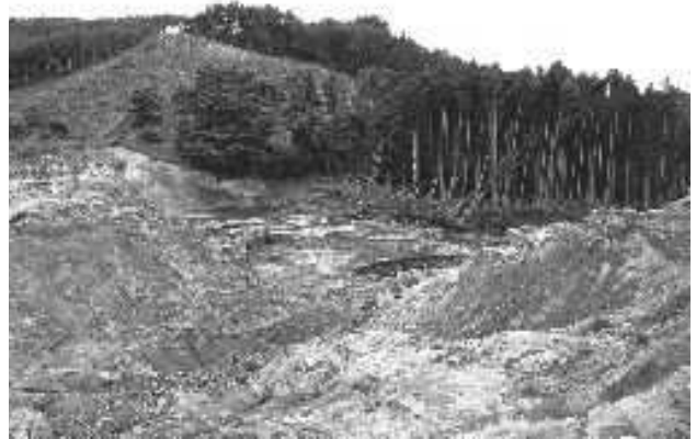
2011年3月11日に発生した東日本大震災で決壊した藤沼ダム跡 (撮影:RPN)
