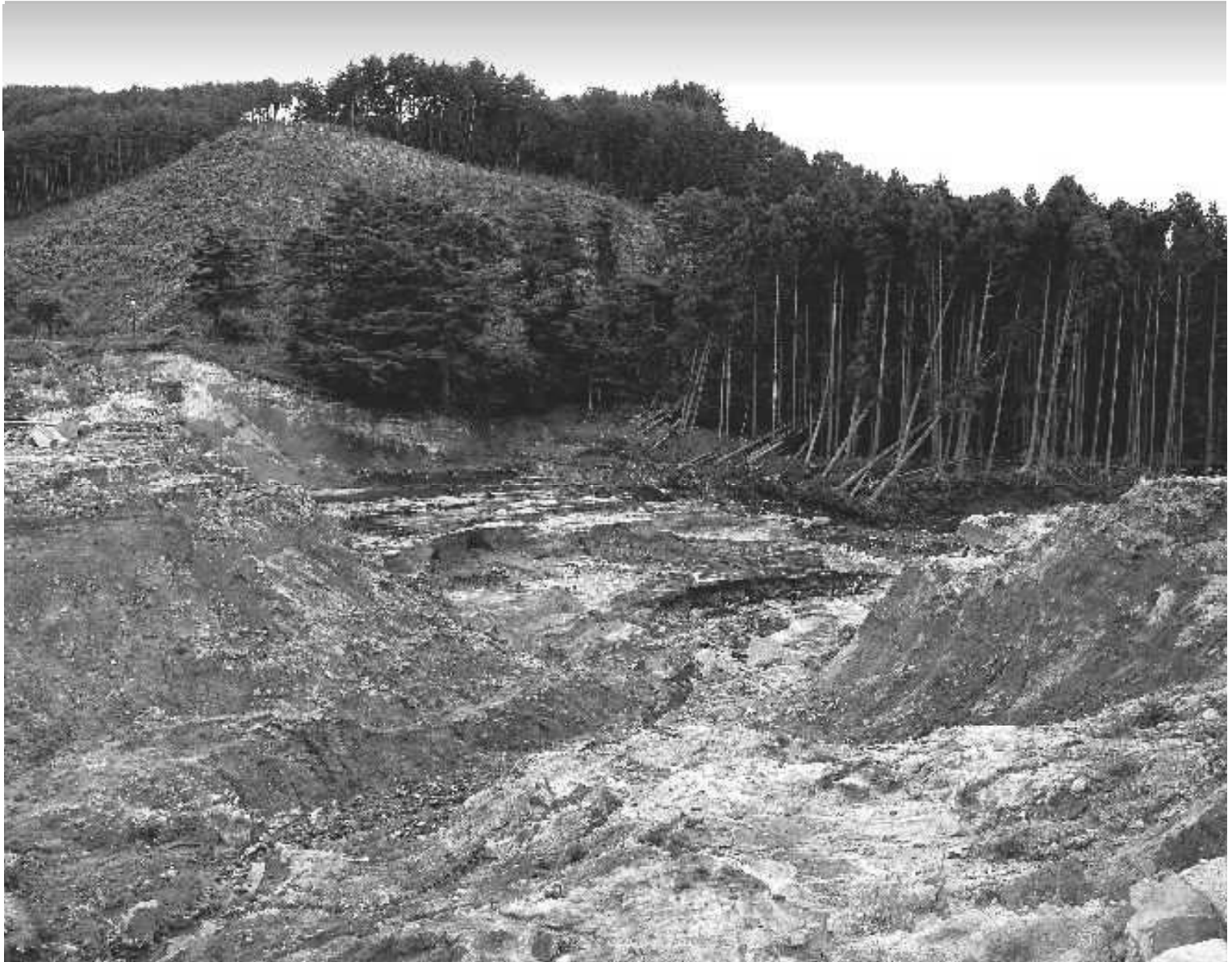
東日本大震災で決壊した藤沼ダム趾(福島県須賀川市)。約150万トンの水が下流域を直撃し、死者行方不明者8名、流失・全壊家屋19戸、床上床下浸水55戸の被害を出した。 Photo by RPN
