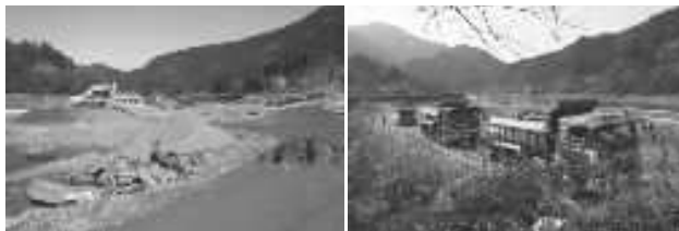
荒瀬ダム湖上流右岸側、佐瀬野地区の土砂除去事業
