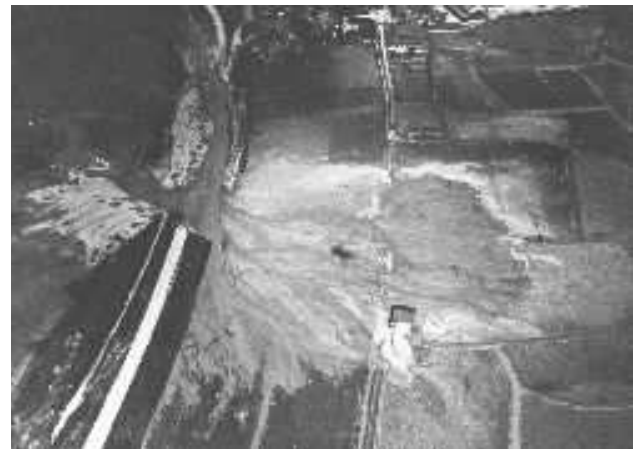
昭和28年台風13号により決壊した大戸川 (写真提供:滋賀県立琵琶湖博物館)
