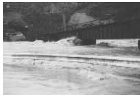
1982年に住民により撮影された鎌瀬の鉄橋ダムの運用で河床が上がり浸水した
